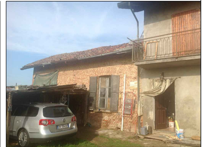
vista edificio oggetto d'intervento
