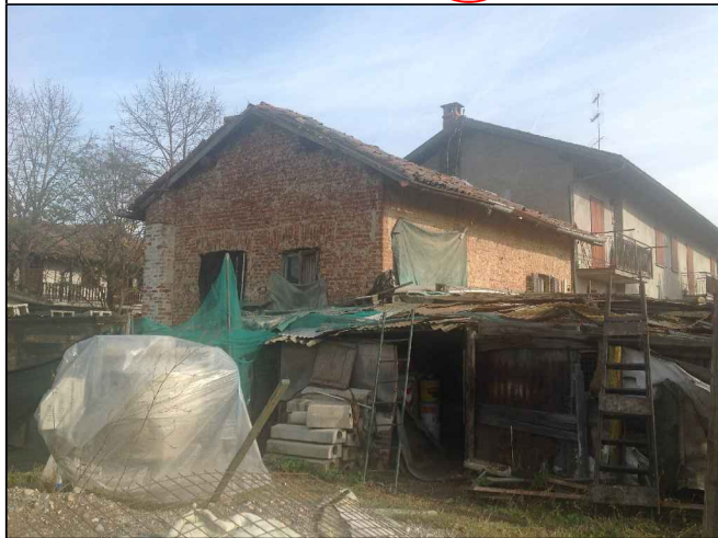
vista testata edificio oggetto d'intervento
