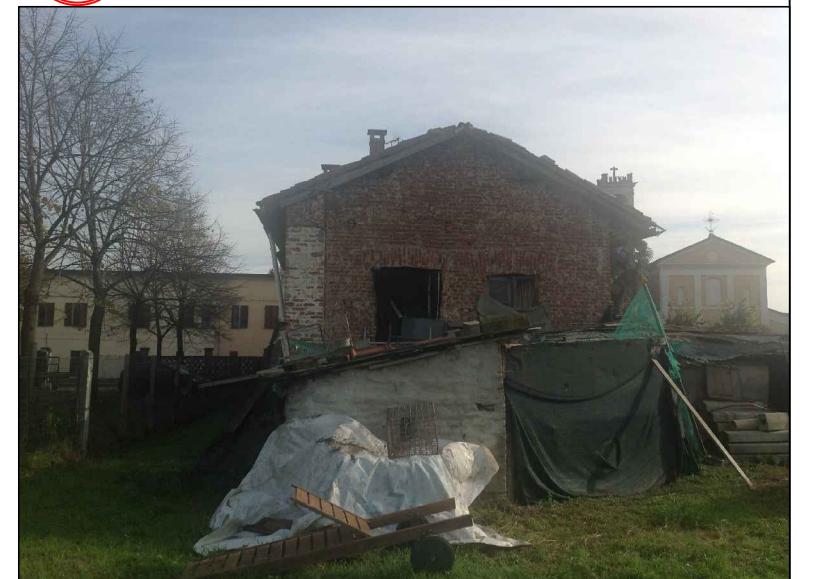
vista testata edificio oggetto d'intervento
