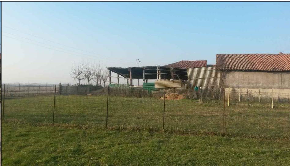
16 vista lotti confinanti proprietà di terzi
