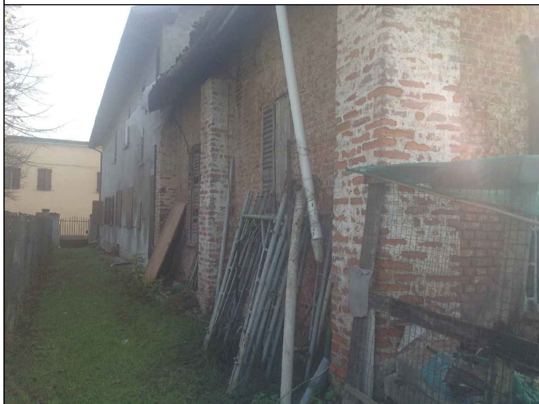
retro edificio oggetto di ristrutturazione
