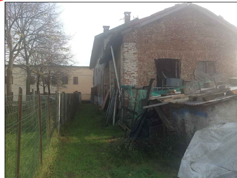
vista passaggio pedonale retrostante all'edificio esistente
