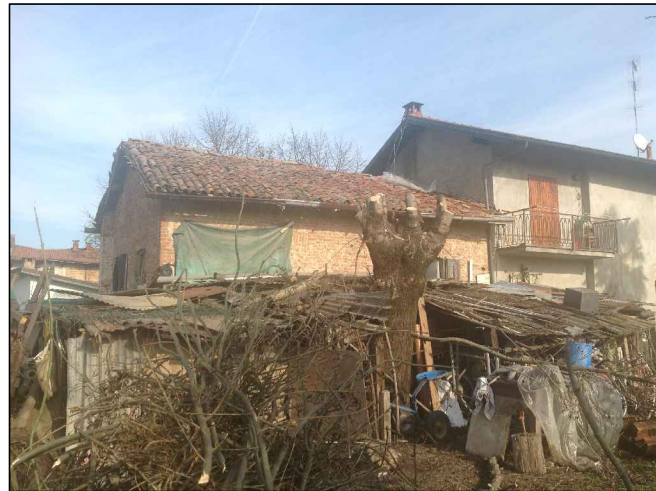
vista edificio oggetto d'intervento
