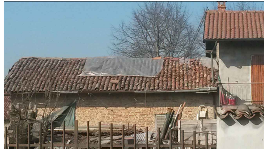
vista edificio oggetto d'intervento
