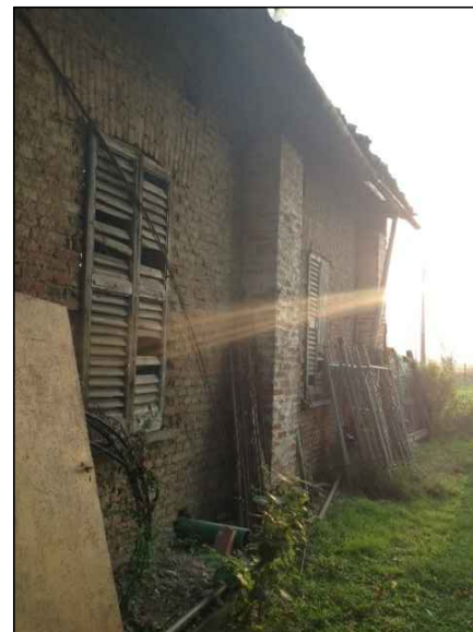
retro edificio oggetto di ristrutturazione
